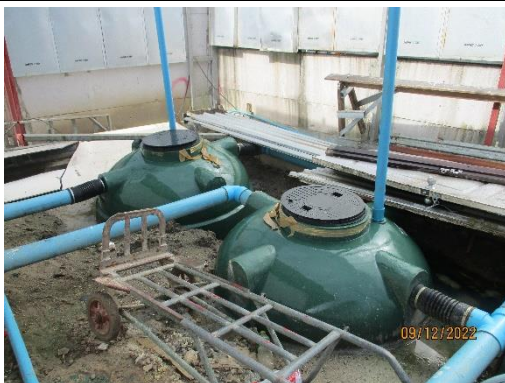
รูปที่ 10 ระบบบำบัดน้ำเสียจากห้องน้ำ
