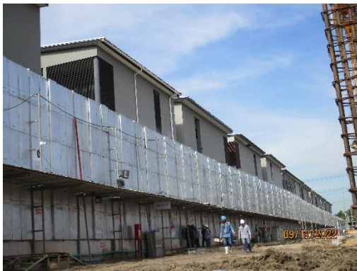
รูปที่ 1 รั้ว Metal Sheet และแผ่นกันเสียง Bloxteg 2-Tuff Series รอบพื้นที่โครงการ
