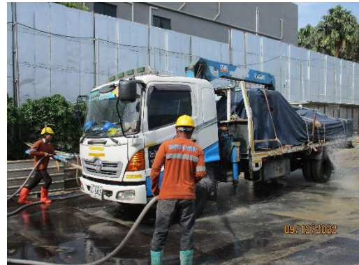
รูปที่ 9 คนงานทำความสะอาดล้อรถบรรทุกก่อนออกจากโครงการ
