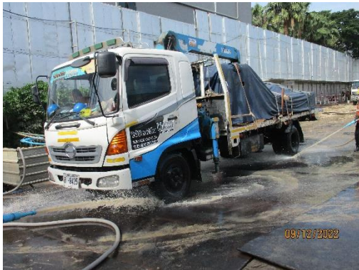
รูปที่ 9 คนงานทำความสะอาดล้อรถบรรทุกก่อนออกจากโครงการ
