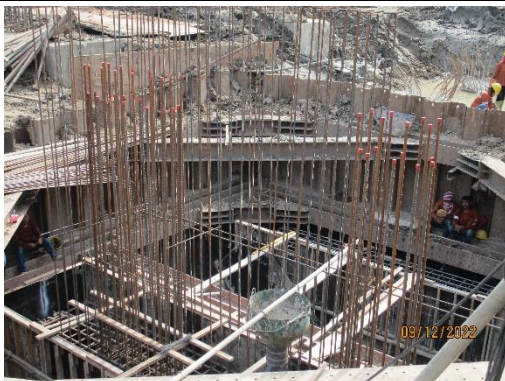
รูปที่ 43 ระบบค้ำยันและระบบป้องกันดินพังด้วย Sheet Pile
