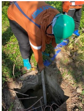
รูปที่ 75 คนงานชุดลอกตะกอนดินที่สะสมในบ่อดักตะกอน
