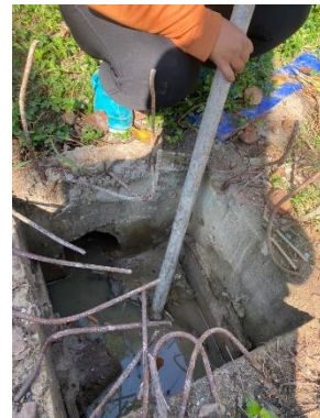
รูปที่ 75 คนงานชุดลอกตะกอนดินที่สะสมในบ่อดักตะกอน
