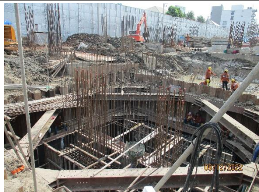
รูปที่ 43 ระบบค้ำยันและระบบป้องกันดินพังด้วย Sheet Pile
